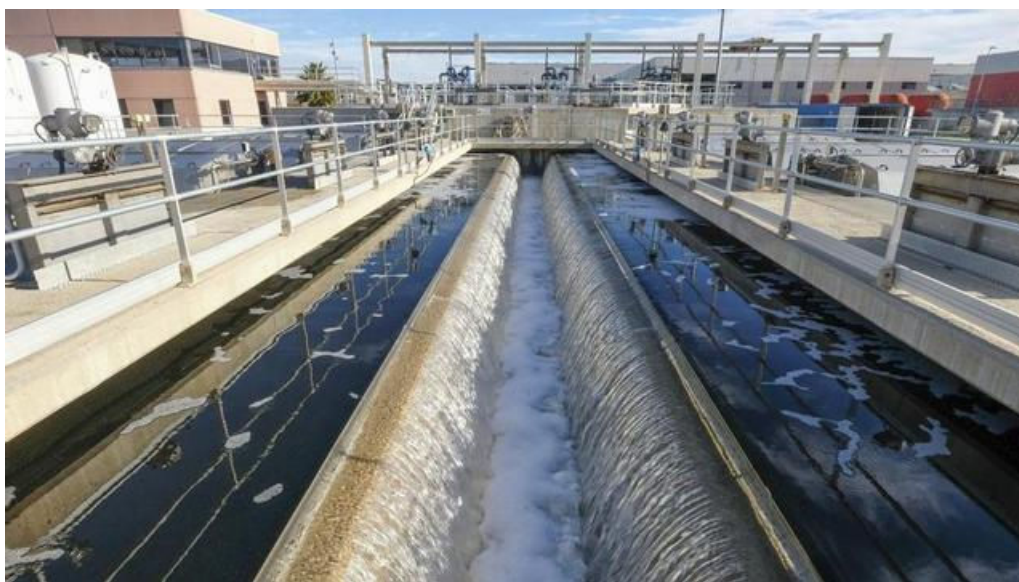
Instal·lacions de la depuradora daigua del Llobregat. | AIGÜES DE BARCELONA
