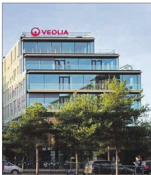
Edificio corporativo de Veolia. EE
